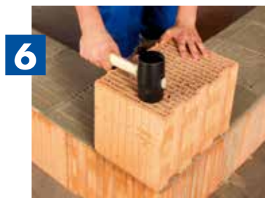
6 Mauerstein wie gewohnt ausrichten
