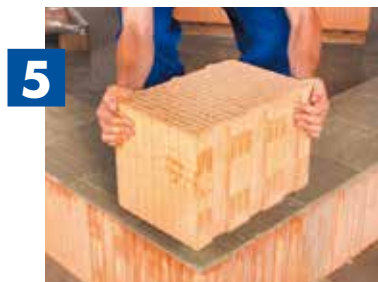
5 Mauerstein vollflächig auflegen
