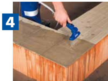
4 maxit mörtelpads bewässern
