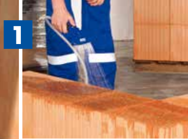
1 Mauersteine befeuchten
