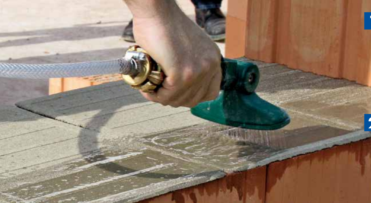
1 Mauersteine befeuchten
